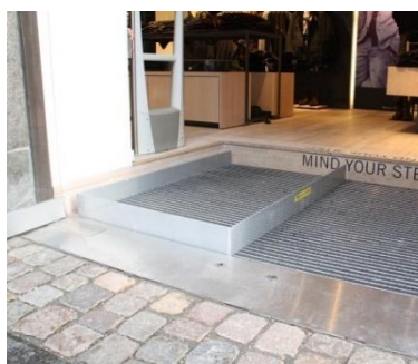
Sikkerhedsskørter kørt op
