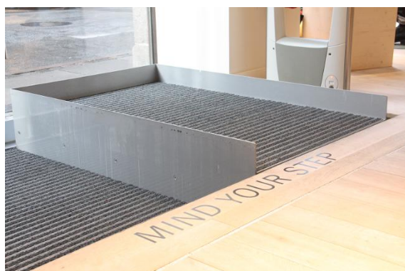
HDN liften klar til brug på øverste niveau
